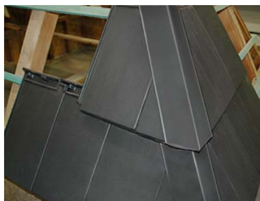
Arêtier en aluminium – 1 par rangée de tuiles, seulement d'application en cas de pentes égales
